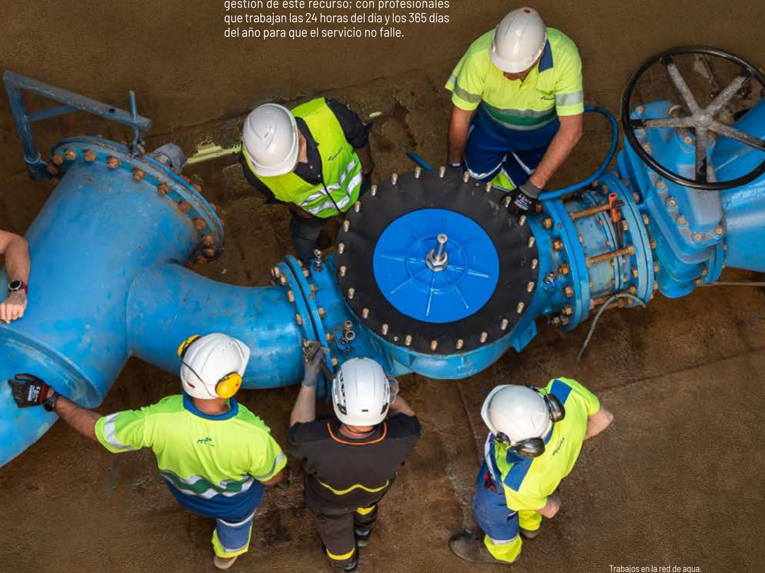
Trabajos en la red de agua.
